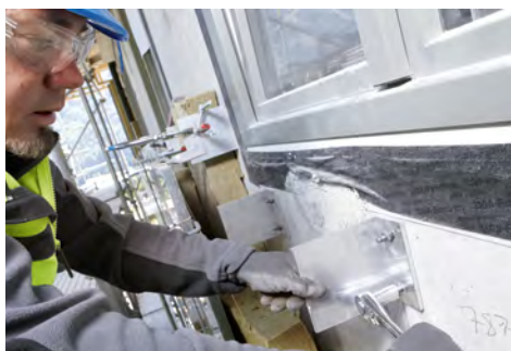
Крепление кронштейнов фасадной системы
