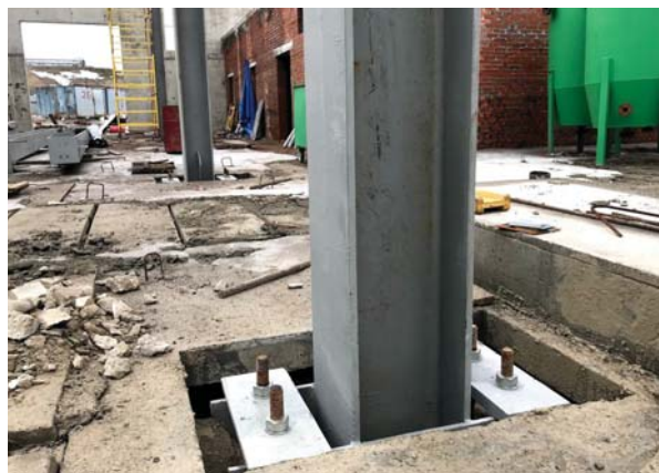
Монтаж стальных колонн
