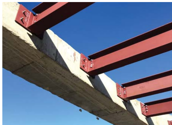
Монтаж стальных балок
