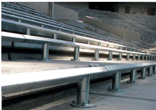
Монтаж кресел стадионов
