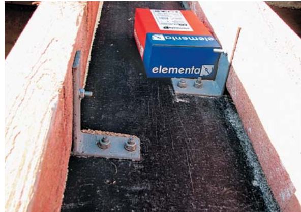
Монтаж стропильных балок
