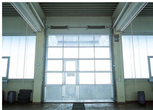
Монтаж автоматических ворот
