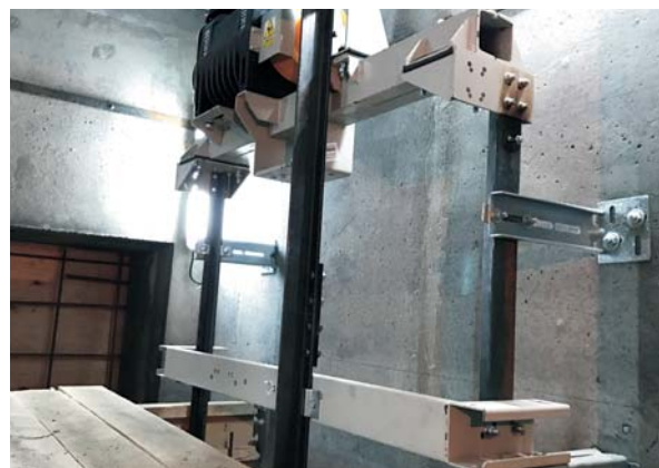
Монтаж лифтовых направляющих
