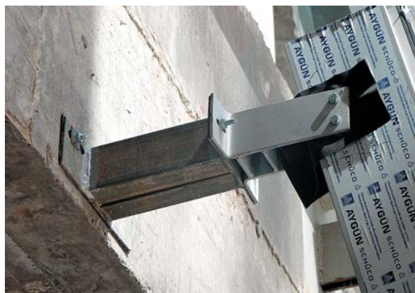
Монтаж светопрозрачных конструкций
