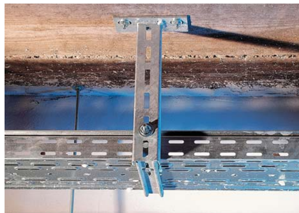
Монтаж инженерных систем
