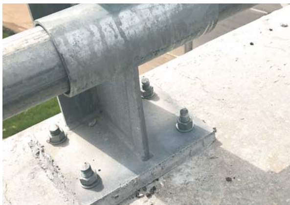
Монтаж дорожных ограждений
