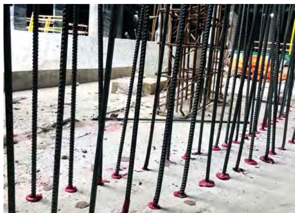
Монтаж арматурных выпусков
