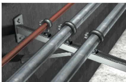
Крепление трубопровода к стене
