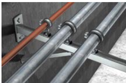
Крепление трубопровода к стене
