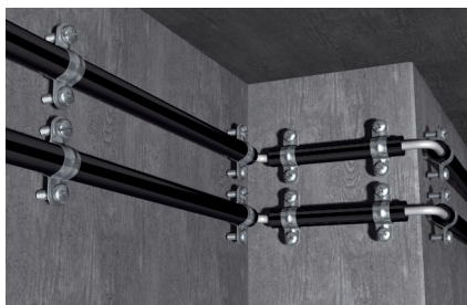
Крепление стальных трубопроводов в защитной оболочке
