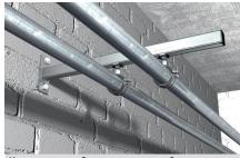
Крепление трубопровода при небольших нагрузках
