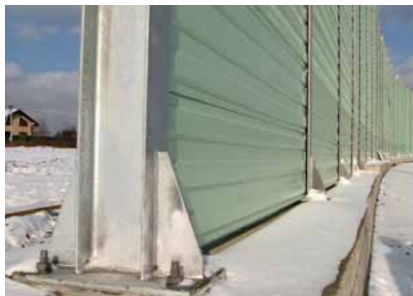
Монтаж шумозащитных экранов
