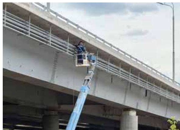
Монтаж кабеленесущих систем
