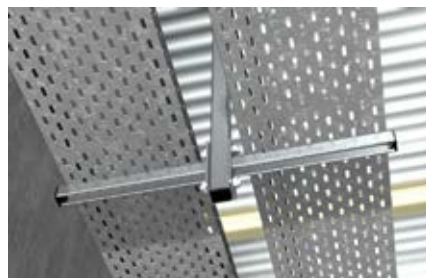
Подвесное крепление кабельных лотков
