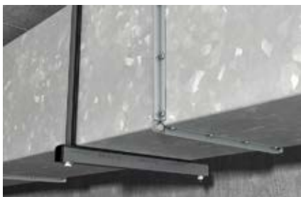
Крепление воздуховода с помощью монтажных шин
