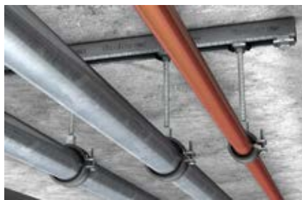
Крепление трубопровода с помощью монтажных шин
