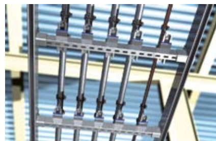
Скользящая опора на монтажной сетке
