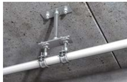
Неподвижное крепление пластиковой трубы
