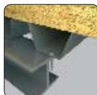
**Применение:** монтаж профилированной жести к стальной конструкции
