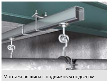
Монтажная шина на стальной балке
