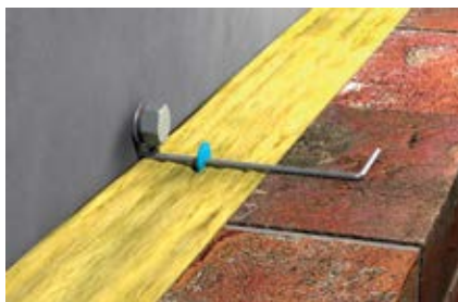
Фасадная кирпичная кладка
