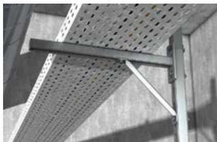
Крепление кабельного канала на консольную конструкцию
